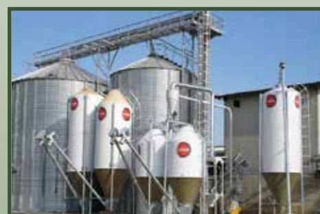
IMPIANTI DI STOCCAGGIO
