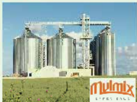
IMPIANTO STOCCAGGIO CEREALI IN LAMIERA ZINCATO
